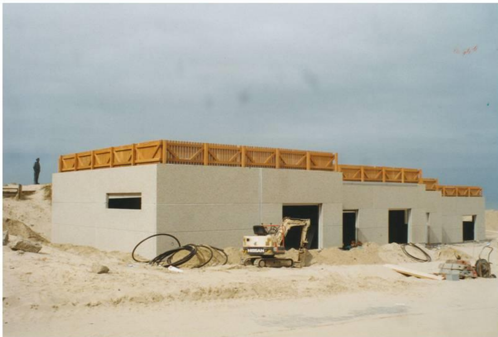
Foto 37. – YC Pannevissers loods met eerst aangelegde houten reling die later op klacht van Esplanade bewoners, wegens gezicht belemmering, vervangen werd door de huidige inox reling.
