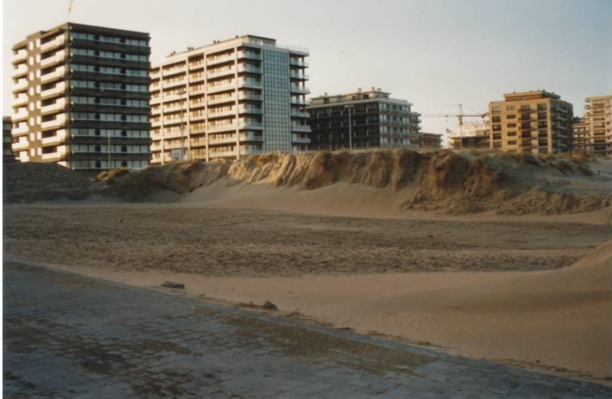
Foto 25.- Zandkliffen na storm aan L1
